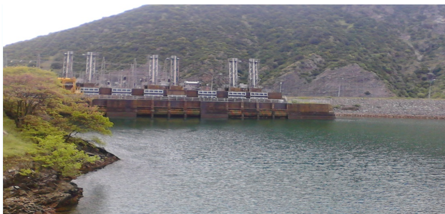
Εικ.3 Υδροηλεκτρικός Σταθμός της Δ.Ε.Η. στον Πολύφυτο
