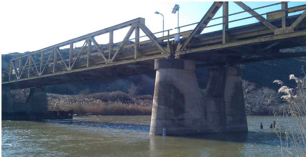
Εικ.5 Τηλεμετρικός σταθμός στη γέφυρα του Στρυμόνα
