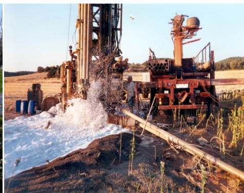
Εικ.2 Εκτέλεση έργου υδροληψίας
